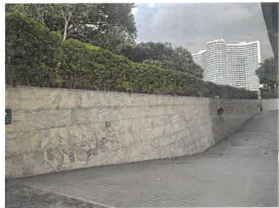
รูปที่ 8 ผนังคอนกรีต เพื่อลดคลื่นจากห้องพักรถยนต์
