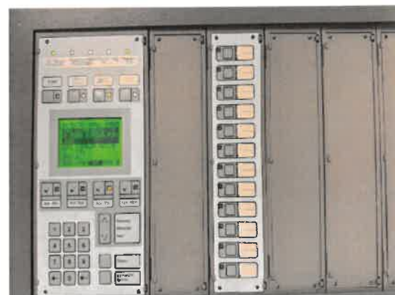
รูปที่ 50 ระบบควบคุมแจ้งเตือนเพลิงไหม้ (Fire Alarm control Panel:FACD)
