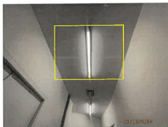
รูปที่ 37 หลอดไฟฟ้าแบบประหยัดไฟ (LED)
