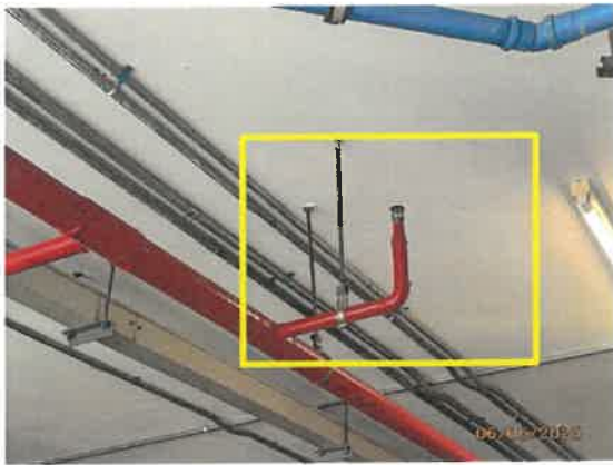
รูปที่ 45 ระบบหัวกระจายน้ำดับเพลิง
