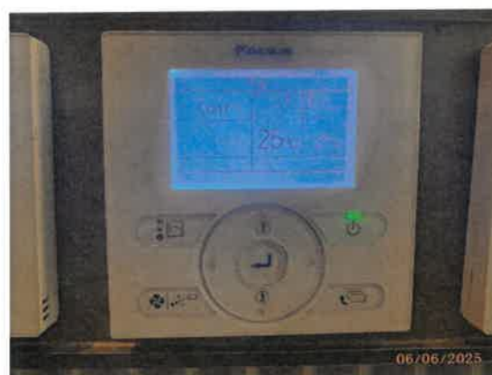
รูปที่ 39 เครื่องตั้งอุณหภูมิ ภายในโครงการให้มีค่า 25 °C
