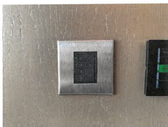
รูปที่ 38 เครื่องปรับระดับแสงสว่าง (Dimmer)
