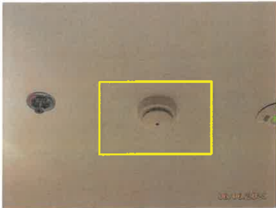
รูปที่ 51 เครื่องตรวจจับควัน (Smoke Detector)
