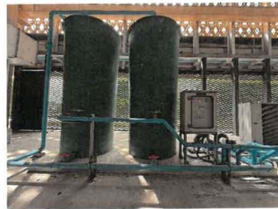
รูปที่ 20 ระบบกำจัดก๊าซมีเทนสำเร็จรูป
