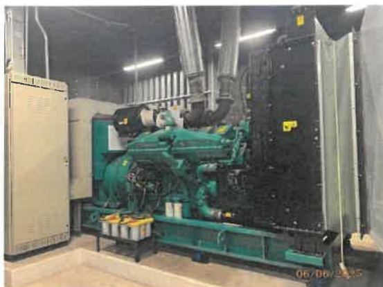
รูปที่ 59 เครื่องกำเนิดไฟฟ้าสำรองของโครงการ
