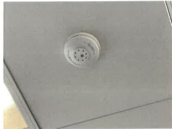
รูปที่ 52 เครื่องจับความร้อน (Heat Detector)
