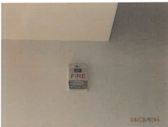
อุปกรณ์แจ้งเตือนอัคคีภัยแบบมีเสียงและแสง
