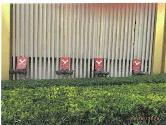
รูปที่ 43 ทิวรับน้ำดับเพลิงภายนอกอาคาร
