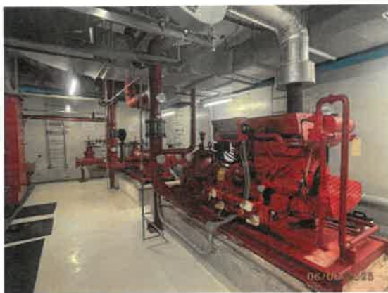
รูปที่ 47 เครื่องสูบน้ำดับเพลิง
