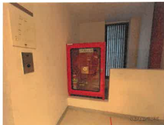
รูปที่ 44 ตู้เก็บสายฉีดน้ำดับเพลิง และป้ายแนะนำการใช้ อุปกรณ์
