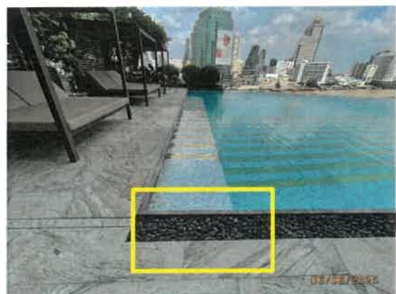
รูปที่ 70 รางระบายน้ำล้นของสระว่ายน้ำ
